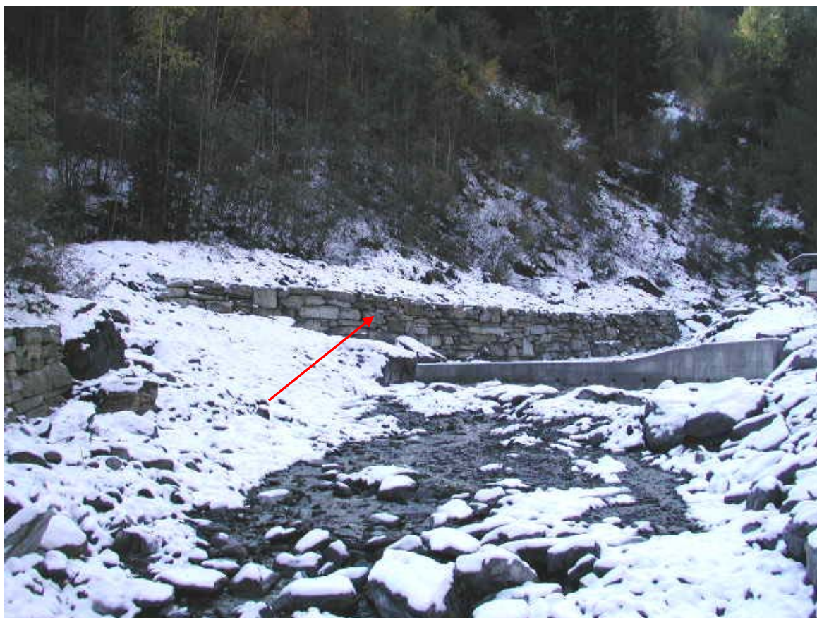
Foto 004 – Opera CANADS004. Dal ponte BATTP0002, verso monte.
