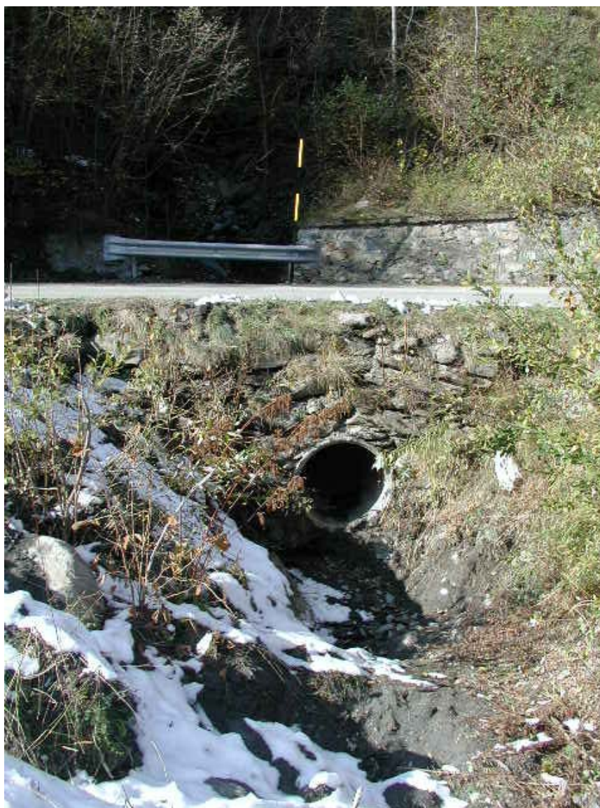
Foto 003 – Opera CANAAG003 . Ripresa da valle dell'opera.
